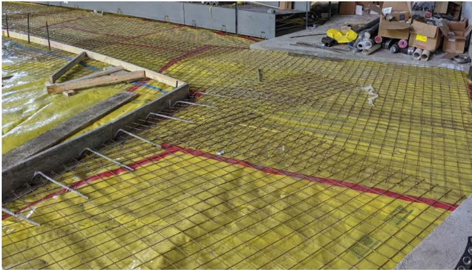
Image 1: Slab reinforcing at auditorium slab - upper pour
