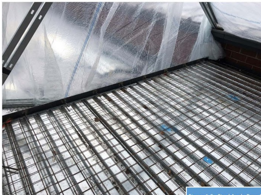
Figure 1-2: Steel Angle Pour Stops
