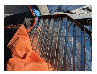
IMAGE 2: STEEL REINFORCING AT CANTILEVER EDGE
