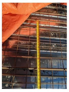
IMAGE 3: STEEL REINFORCING AT CANTILEVER EDGE
